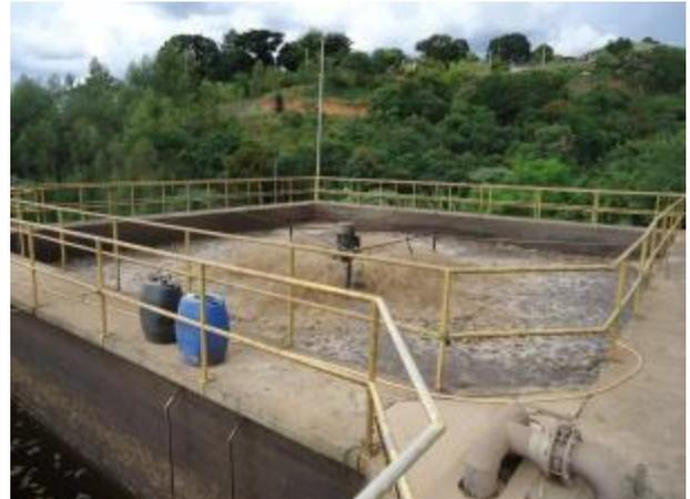
**Foto 4.35 – Reator com Aerador em Operação**
