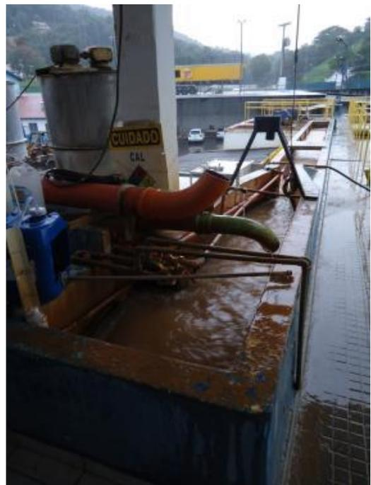
**Foto 4.5 – Canal de Entrada da Água Bruta – Calha Parshall com Medidor Ultrassônico**
