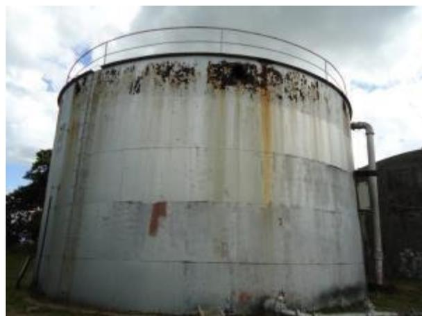
Foto 4.18 – Centro de Reservação Principal – R-02 com Marcas de Corrosão
