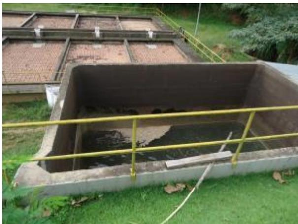
**Foto 4.38 – Tanque de Contato**
