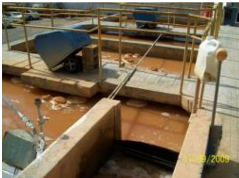
**Foto 4.6 – Flocculadores com Agitadores Mecânicos**
