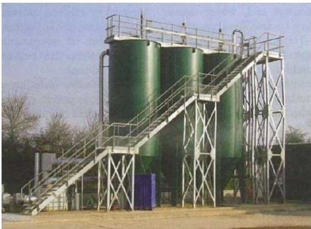
**Figura 1: Esquema geral do sistema de filtração terciária através da tecnologia do Filtro.**
